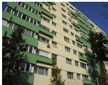
CONSTRUCTII CIVILE SI REABILITARI DE BLOCURI
